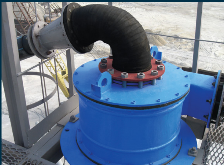
Установка резинового отвода в гидроциклоне
